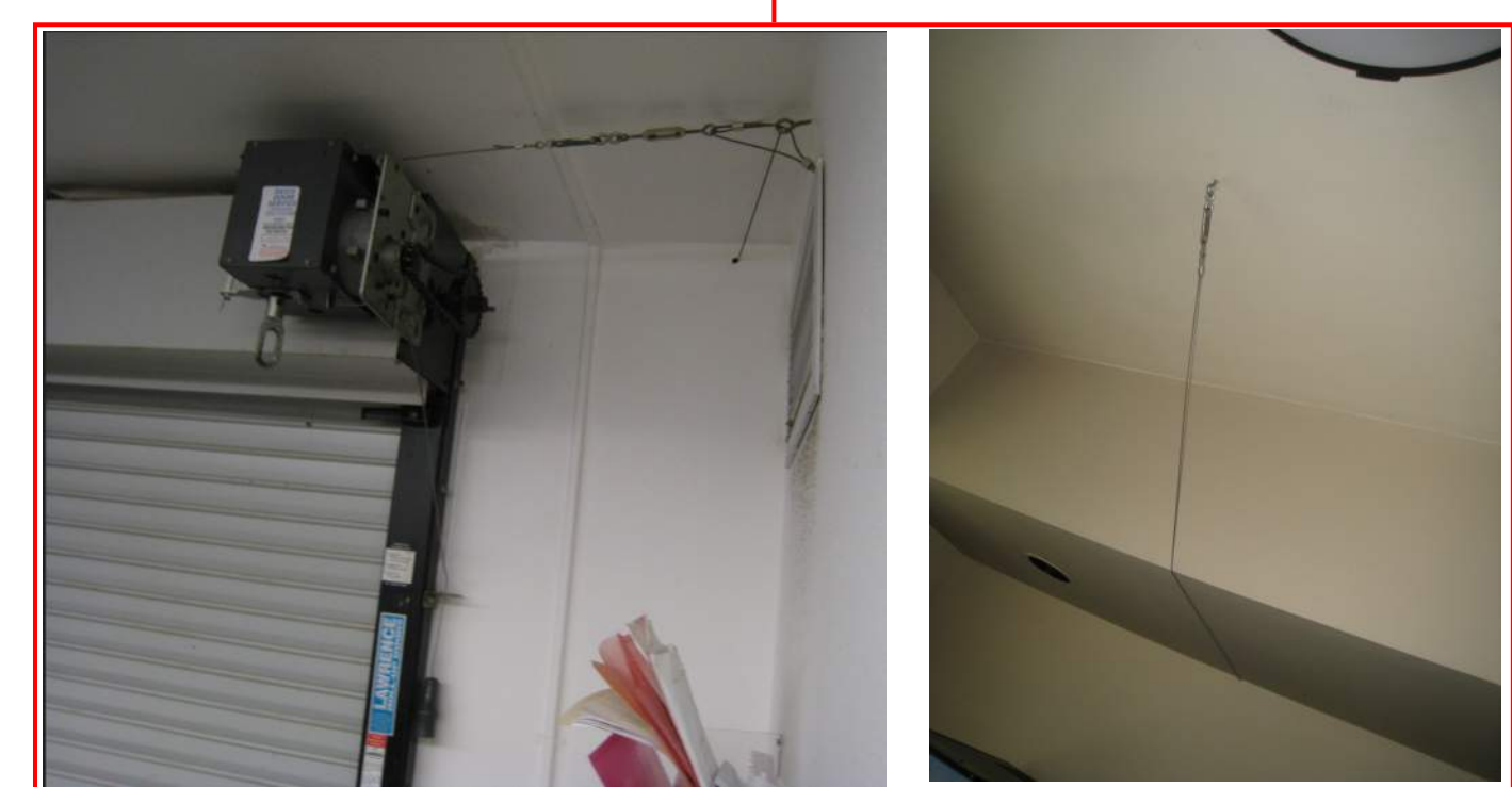
ROLL DOWN FIRE DOOR
